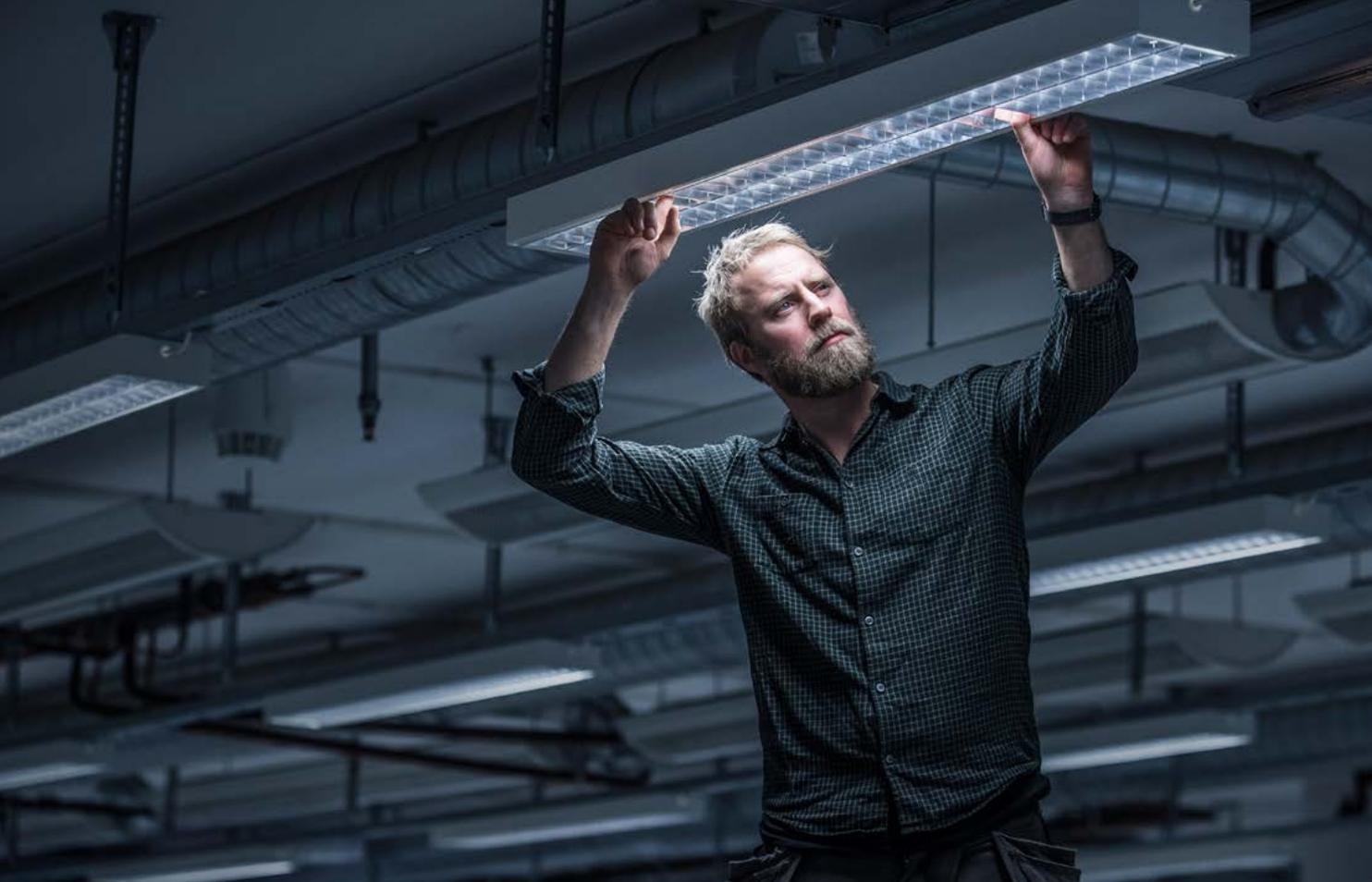
**O sistema de iluminação pode ser facilmente programado, através de uma aplicação intuitiva,** para oferecer uma ampla gama de vantagens de iluminação inteligente. Estas vantagens vão do Bluetooth às vantagens adicionais de um sistema baseado na nuvem, bastando para tal adicionar um gateway à instalação.
