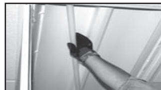
Figura 8. Instalación de las lámparas
