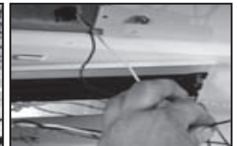
Figure 5. Insertion des fils d'alimentation dans le raccord rapide
