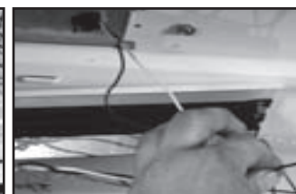
Figure 5. Insertion des fils d'alimentation dans le raccord rapide
